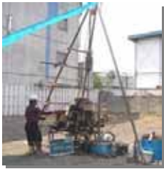
ボーリング調査
