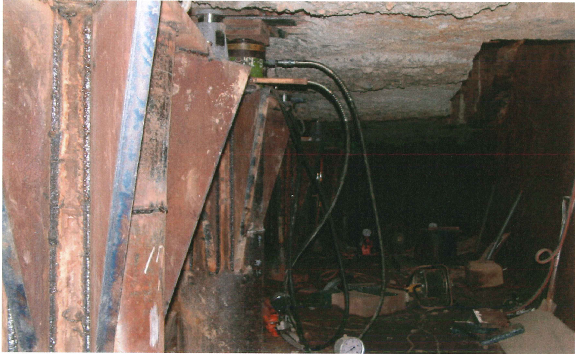
図③はロードセルを持って支持力の確認を行っているところ。柱の下は75t確認。
